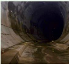
昔から「暴れ川」として常に水害に悩まされ続けた鶴見川の洪水対策として建設された、恩廻公園調節池。地下には延長約600m、直径約15~16mのトンネル構造の施設があり、日本でも最大級の断面積を有しています。『翔んで埼玉』では、壇ノ浦百美(二階堂ふみ)と麻実麗(GACKT)が踊りながら地下神殿に向かう地下通路のシーンの撮影が行われました。
